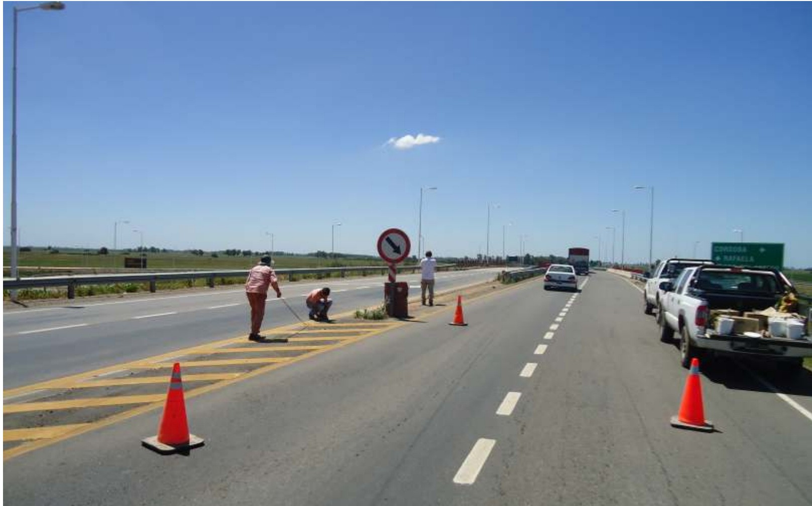
Inspección de la Obra "Transformación en Autovía Ruta Nacional 19". En tres de los cinco tramos en los que se dividió la totalidad del trabajo.
